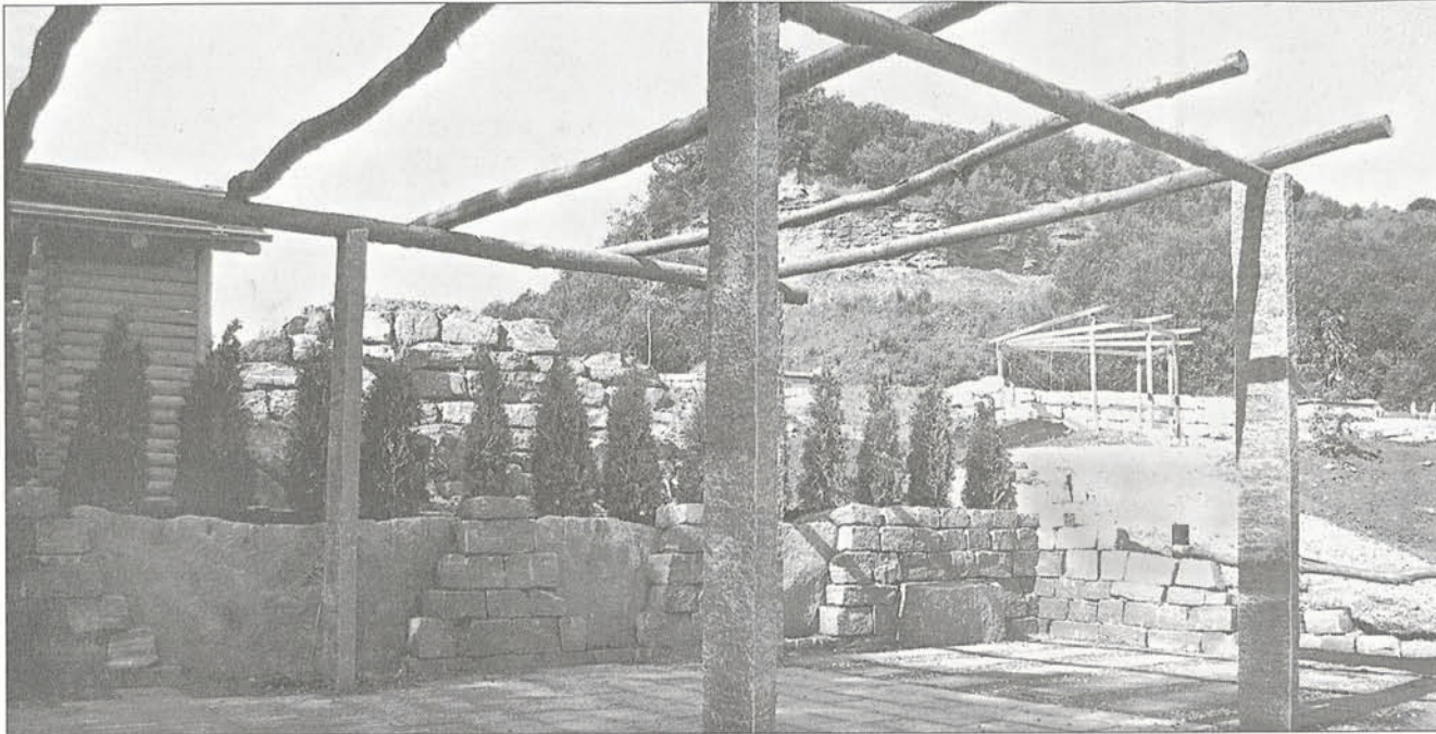
Stein in Kombination mit Holz: Der Tessinergarten wirkt massiv und leicht zugleich.
