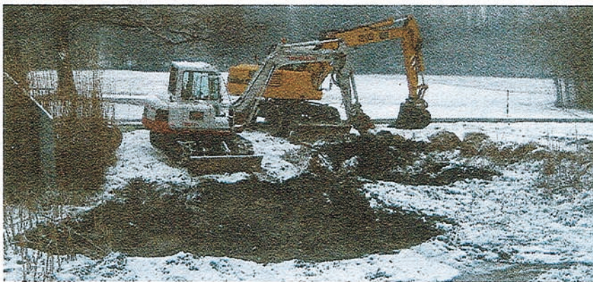
Die Stadt hatte ein Unternehmen beauftragt, den Faulschlamm aus den beiden unteren Friedhofsweihern zu entfernen. Insgesamt 400 Kubikmeter wurden herausgebaggert.
